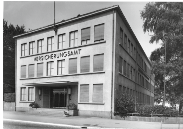
Altes AVA-Gebäude in Aarau
