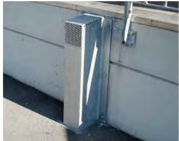
Ungesichertes Entlüftungsrrohr, das mit einem «Schnorchel» versehen wurde
