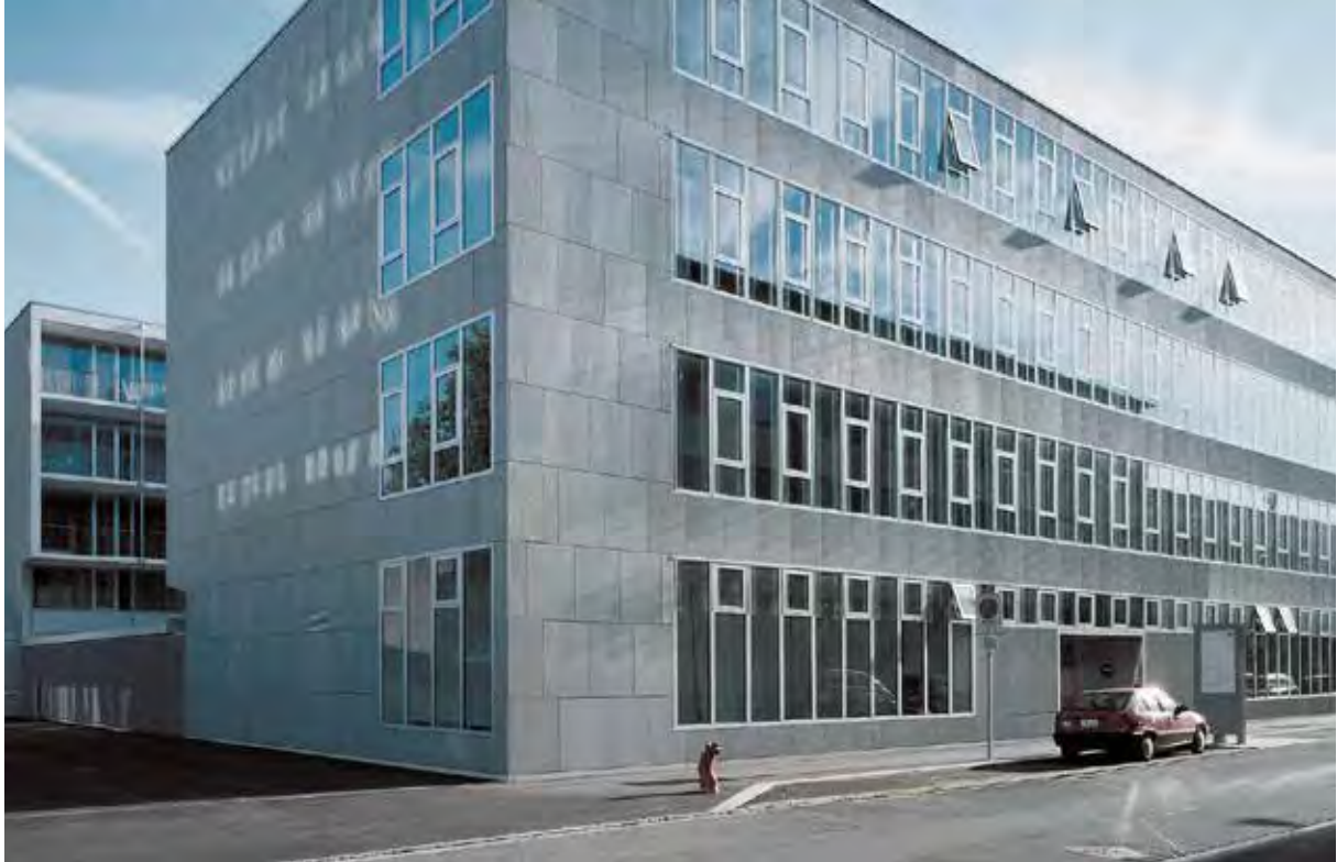
Das Gebäude der Aargauischen Gebäudeversicherung in Aarau
