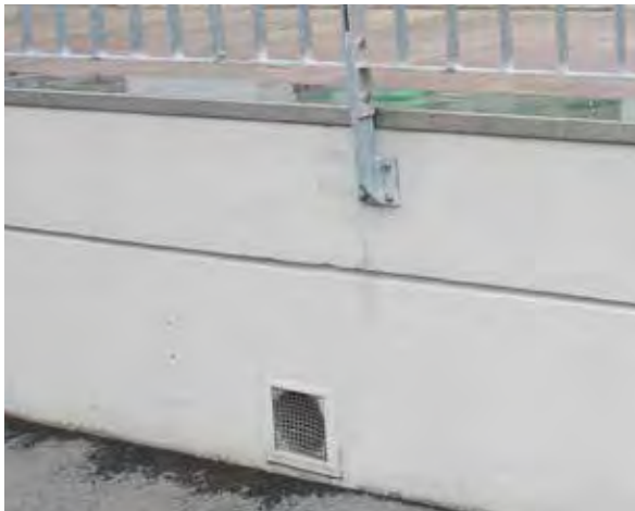
Ungesichertes Entlüftungsrrohr, das mit einem «Schnorchel» versehen wurde
