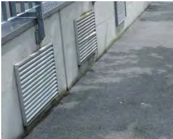
Überschwemmungsgefährdete Entlüftungsschächte, die hochwassersicher gemacht wurden
