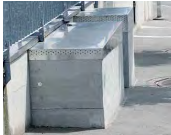
Überschwemmungsgefährdete Entlüftungsschächte, die hochwassersicher gemacht wurden
