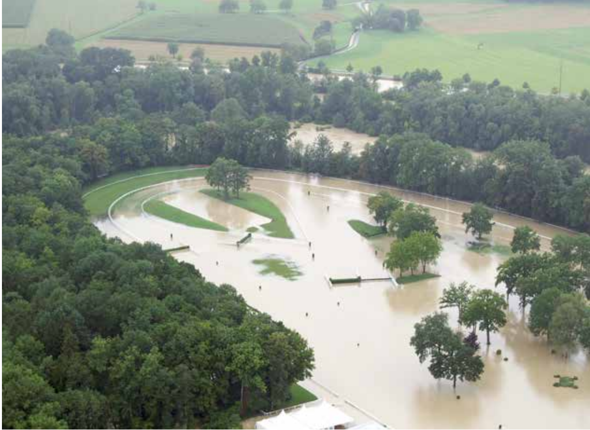
■ Pferdezentrum Aarau, Hochwasser August 2007
