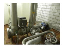
Nach dem eher theoretischen Teil folgt die Zustandskontrolle von Pumpwerken und Reservoiren. Dabei wird unter anderem ersichtlich, ob die ausgelöste Löschklappe nun auch tatsächlich den freien Durchfluss des Löschwassers gewährt.
