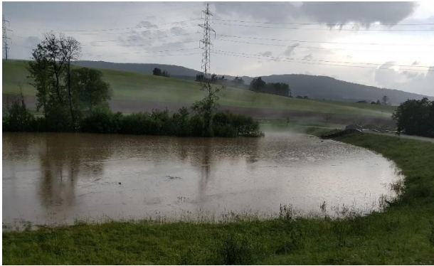
Abb. 4: Das eingestaute Rückhaltebecken Ried in Ehrendingen am 30. Mai 2018, 2014 in Betrieb genommen als Teil des Projekts Hochwasserschutz Surbtal
