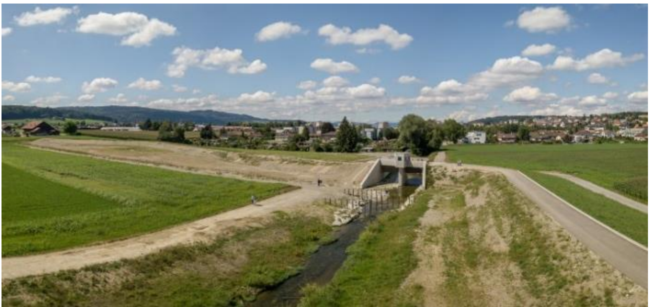
Abb. 5: Das Rückhaltebecken Wohlen wurde 2015 in Betrieb genommen als Teil des regionalen Hochwasserschutzes Bünztal
