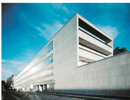
Blick von Fussgängerunterführung beim Bahnhof
