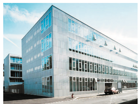
Blick von Herzogstrasse Anfahrt mit Auto
