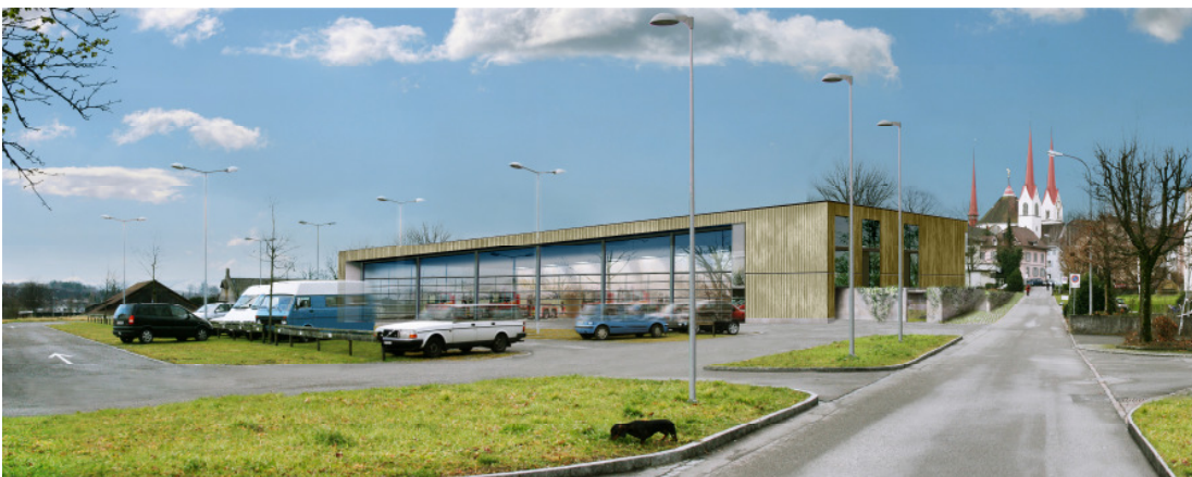
Blick auf die Torfront (Nordfassade)
